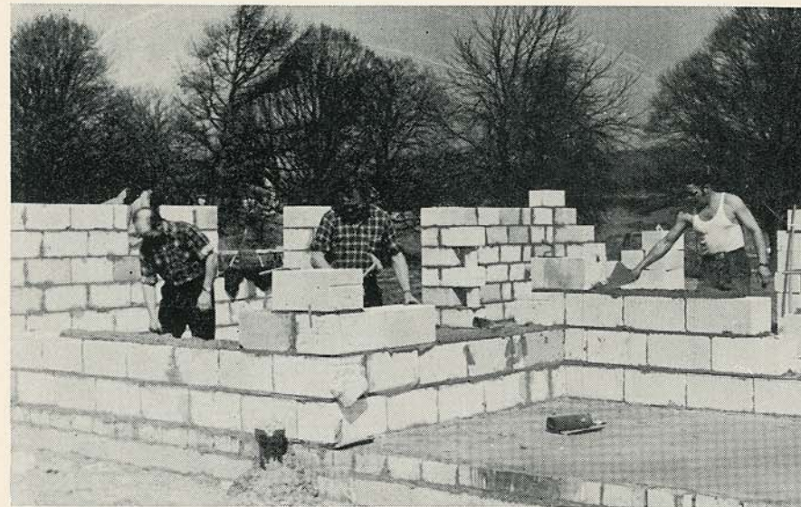
Bauarbeiten am Sportheim. Von links: Friedrich Koch, Gerhard und Josef Pape.
